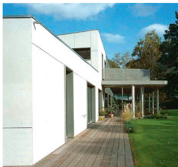
Рис. 3. Частный дом: фасадные панели, изготовленные из белого цемента
