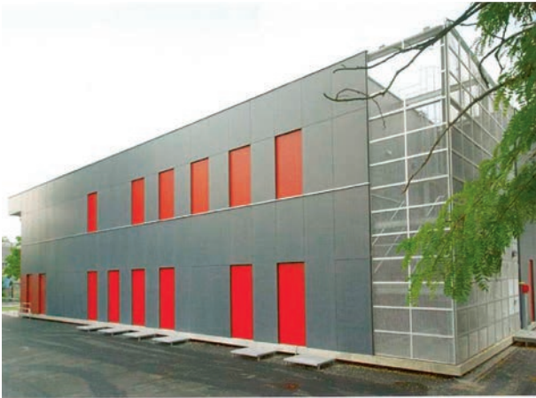
Рис. 2. Культурно-спортивный центр: рельеф фасада с закрытыми раздвижными ставнями из фиброцемента Fig. 2. Community centre: Facade relief with closed sliding shutters of fibre cement
